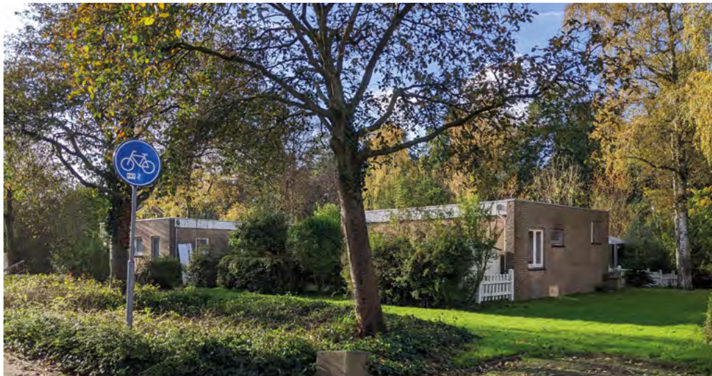
Bestaande situatie Van Balenstraat
