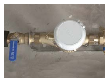
Watermeter met kapje en hoofdafsluiter
